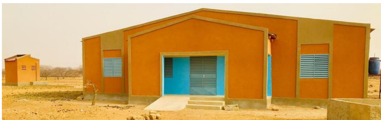
Photo 10: Construction d'un CSPS de Gorom-Gorom
