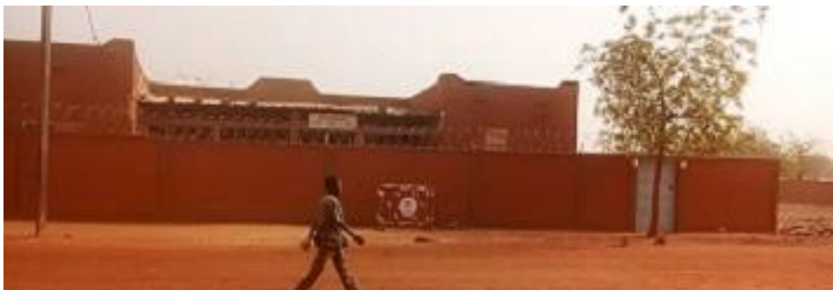
Photo 8: Construction de la clôture de la préfecture de Djibo
