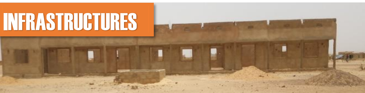
Photo 4: Bâtiment en construction à Titao
