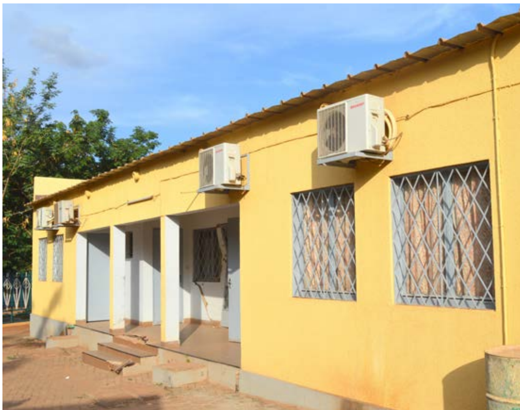
Réhabilitation du bâtiment abritant les guichets de diverses opérations du MINEFID
