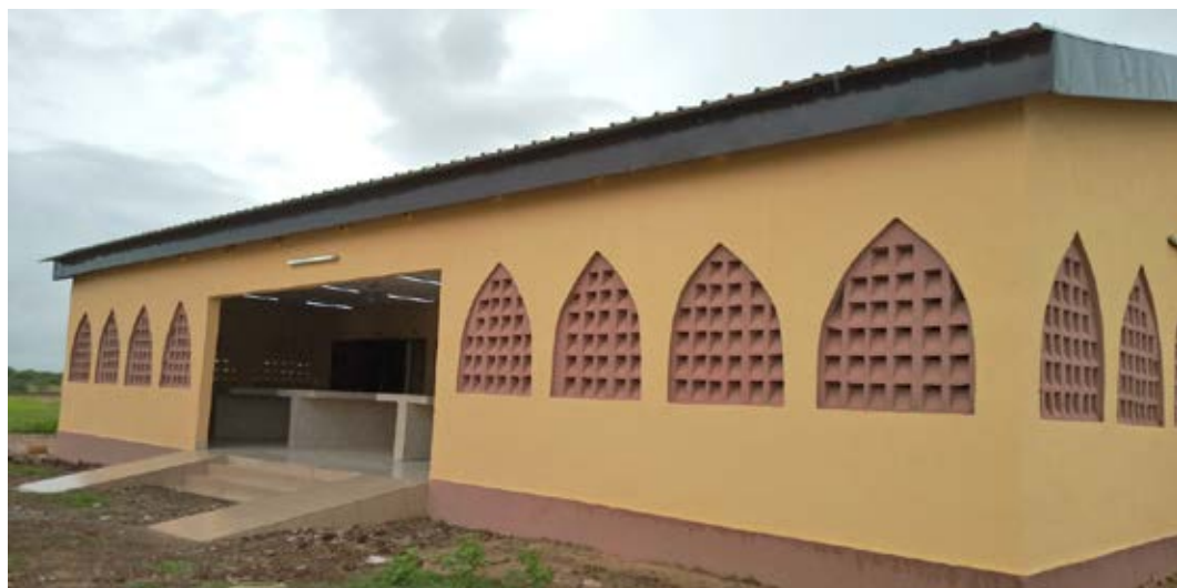
Restaurant de la gare routière de Dori avec rampes d'accès
