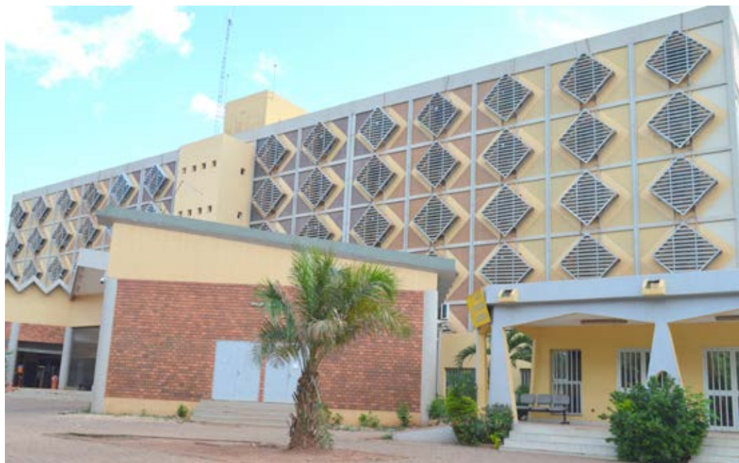
Réhabilitation du bâtiment R+4 du MINEFID
