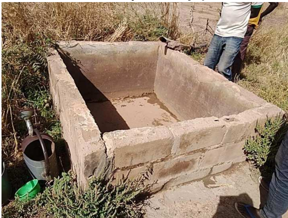
Photo 2 : structure inamovible dans l'emprise du sous-projet
