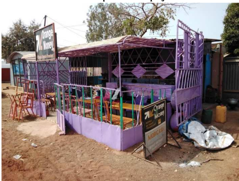
Photo 1 : structure amovible dans l'emprise du sous-projet
